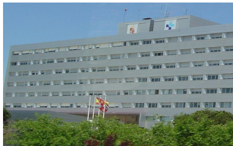
Fachada del Hospital de Ávila.
